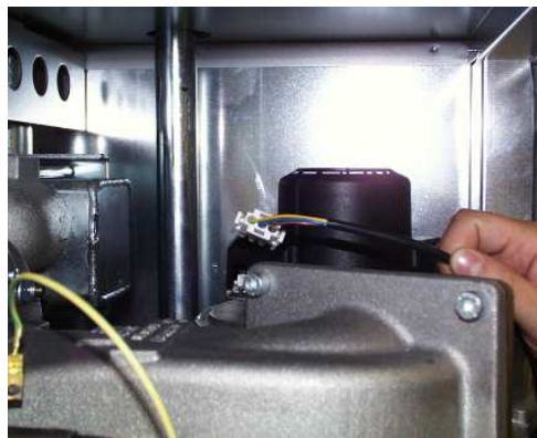
Εικόνα: Ξεβιδώστε όλες τις ηλεκτρικές συνδέσεις στον ανεμιστήρα και στον μετασχηματιστή ανάφλεξης
