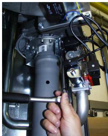
Εικόνα: Ξεβιδώστε τις βίδες μεταξύ ανεμιστήρα και θαλάμου ανάμιξης
